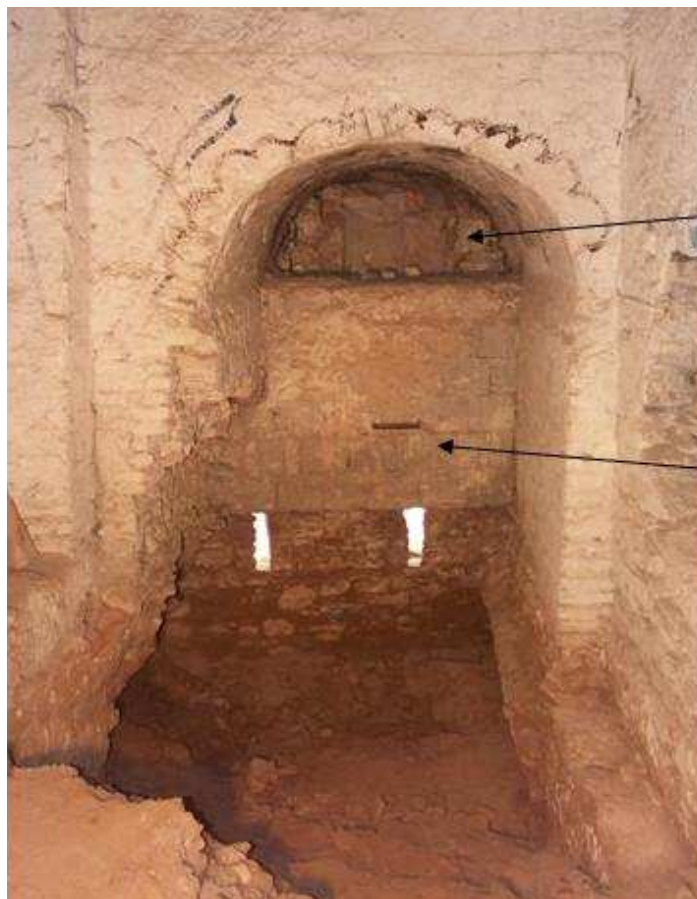
ABB. 14: BLICK VON DER KASEMATTE AUF DEN DURCHGANG ZUR BASTION
