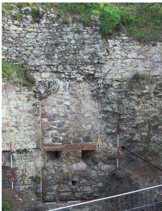
ABB. 9: GEWÖLBANSATZ (BEF. 11) AN UND IN DER BASTION.
