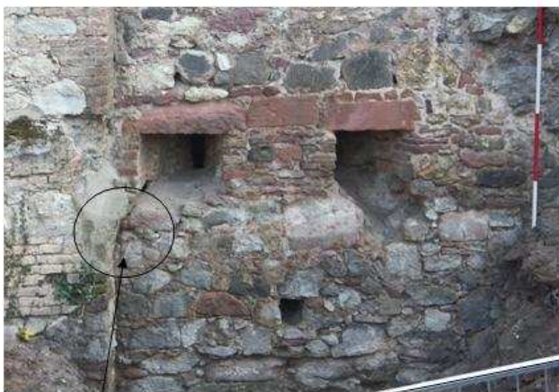
Gewölbeansatz von außen (links) wie von innen (rechts).
